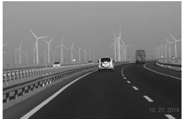
甘粛省張掖市の高速道路から望む風力発電塔。無数の発電塔が数十kmにわたり遙か遠方まで林立していた。
