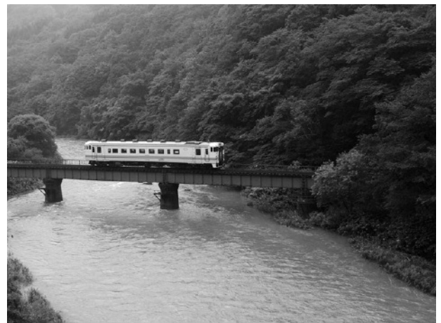
写真2. 景勝地にある第1天ノ川橋梁を渡る
