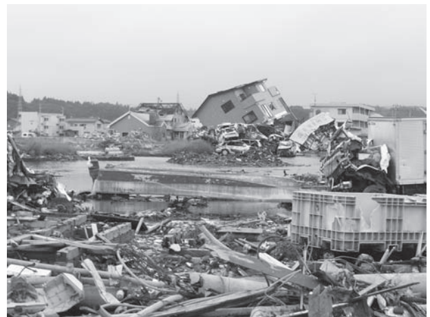
気仙沼市の被災状況
