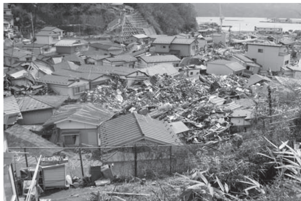
図1 津波で押し流された住宅
