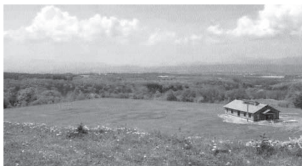
外観が完成した「森の案内所(事務棟)」
