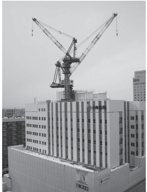
これ、貴重な写真です。2月の数日間、タワークレーンが2台も活躍しました。
