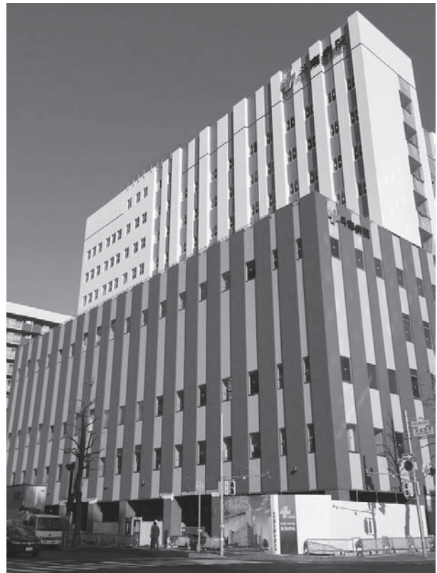
今は仮囲いも撤去され、内装・外構工事が急ピッチで進んでいます（4月1日撮影）。
