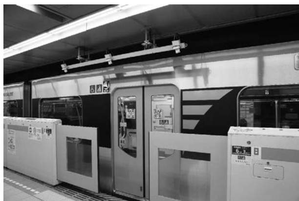
新型QRコードの貼られた乗降ドアと天井吊り下げ式の読み取りカメラ、その前方にホームドア
